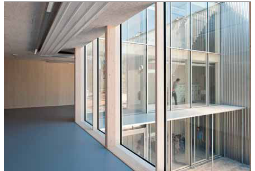
Eingebaute Fenster mit Rahmen aus PEFC-zertifiziertem Holz
