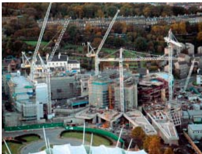
Hier entsteht das neue schottische Parlament
