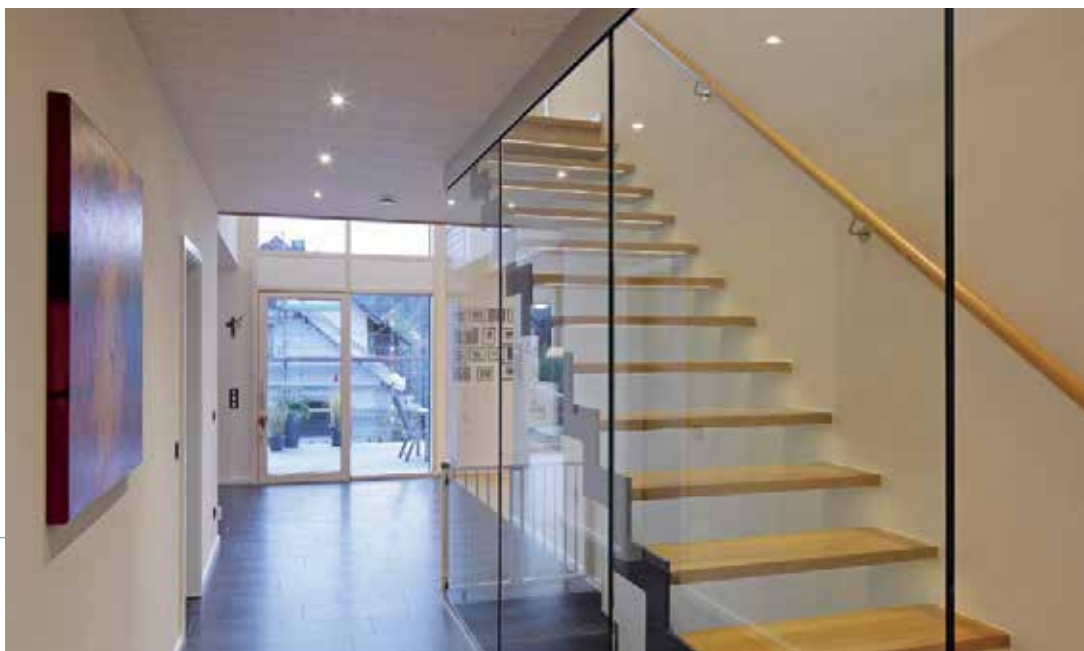
Um die Offenheit des Treppenhauses zu unterstreichen, wurden raumhohe Verglasungen zur Absturz-sicherung sowie Glasbrüstungen verwendet.
