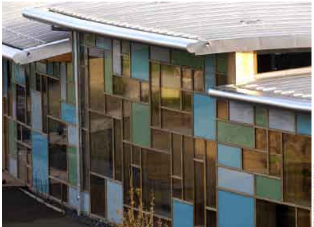
Die Fassade besteht aus emailliertem Glas und Pfosten aus Lärche
