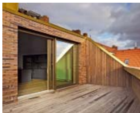
Die Deckschale der Hebe-Schiebe-Tür-Elemente sind passend zum Kupferblech der Dachdeckung ausgeführt.
